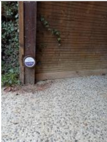
repère normalisé du débordement de la Prêle
