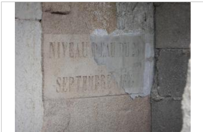
Pierre gravé sur la façade de la maison en face
