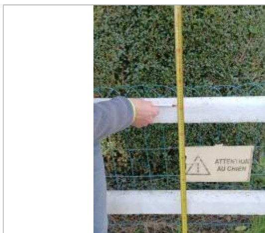
Laisse de crue à 91 cm/sol.
