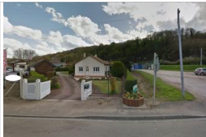
Muret sur façade de la maison, 41 rue des Canadiens.
