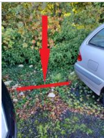
laisse de crue au sol affleure le bitume du parking.
