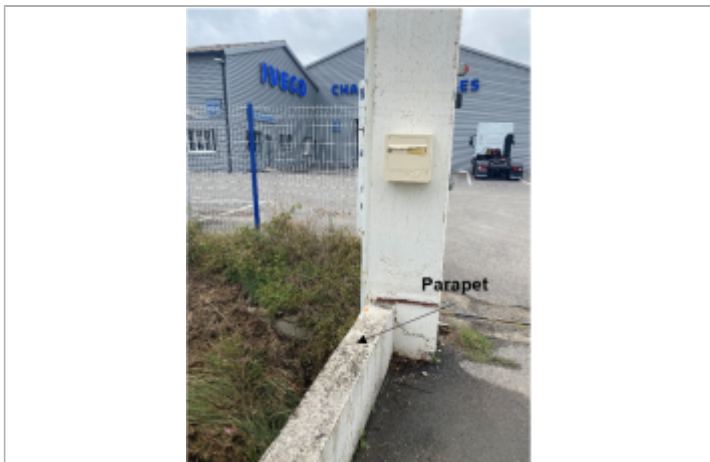
Niveau atteint est 97 cm en dessous du niveau haut du parapet
