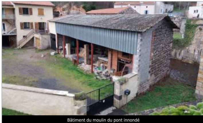
Bâtiment du moulin du pont inondé
