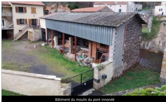
Bâtiment du moulin du pont inondé
