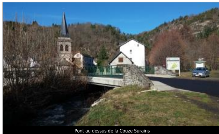
Pont au dessus de la Couze Surains
