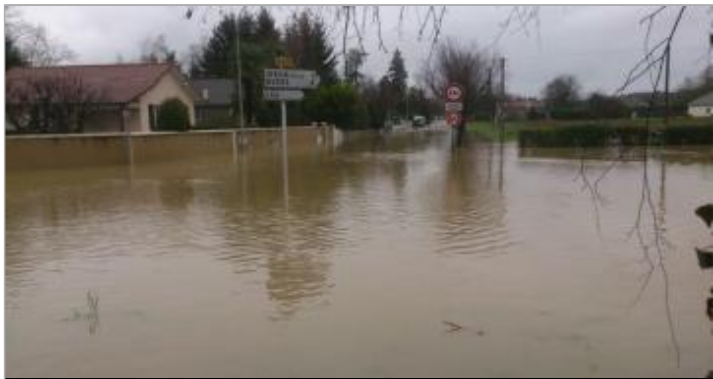
Vue du repère durant la crue - Auteur : SAFEGE/DDTM 64
