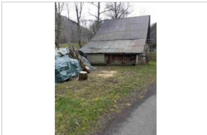
Grange de stockage de bois à Voissières
