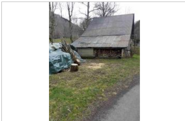
Grange de stockage de bois à Voissière
