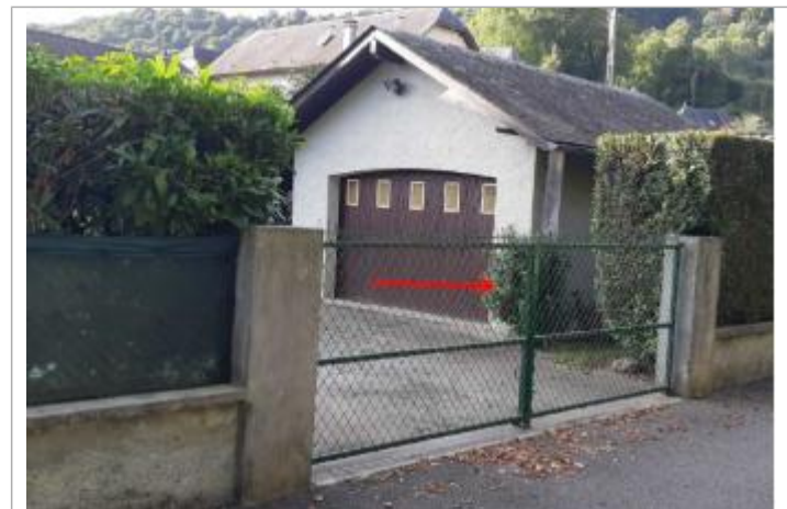
Vue du repère (la flèche rouge représente le niveau atteint par les eaux sur la porte du garage) - Auteur : HEA/DDTM 64
