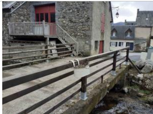
Pont face à la maison au dessus de la Couze Chambon
