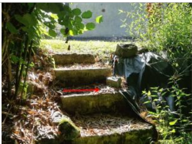
Vue du repère (la flèche rouge représente le niveau atteint par les eaux) - Auteur : HEA
