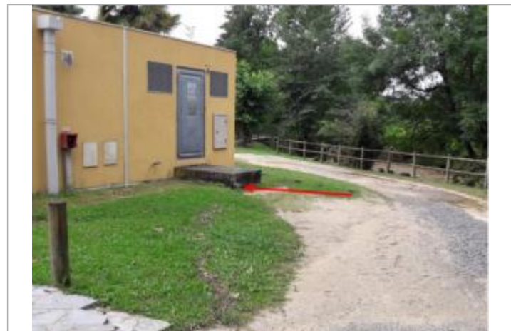
Vue du repère (la flèche rouge représente le niveau atteint par les eaux) - Auteur : HEA/DDTM 64
