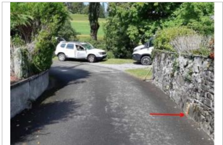
Vue du repère (la flèche rouge représente le niveau atteint par les eaux au niveau du sol) - Auteur : HEA
