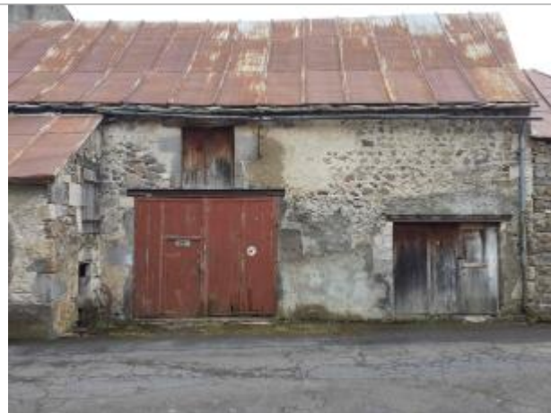
Repère de crue au droit de la grange
