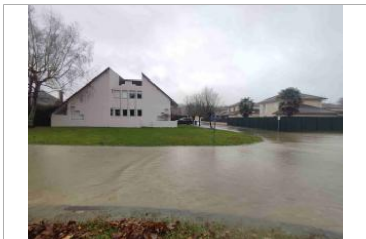
Vue du repère durant la crue - Auteur : SMBGP
