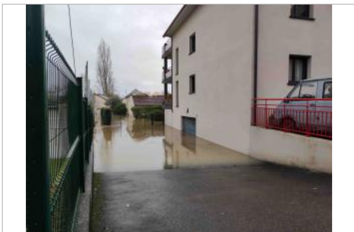
Vue du repère durant la crue - Auteur : SMBGP
