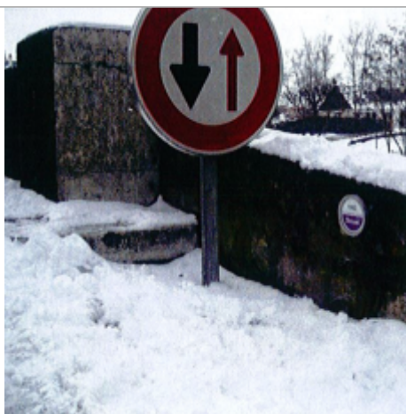
Repere Pont de Chace 1983
