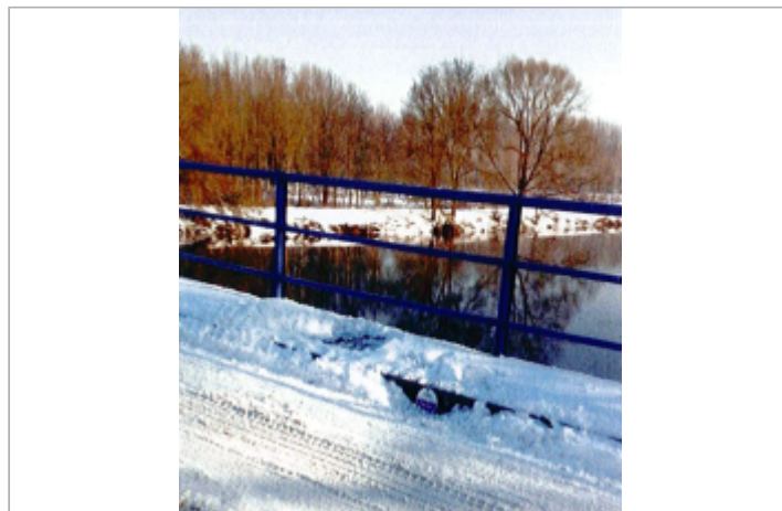
Site Saint-Just à Pont de Gastines
