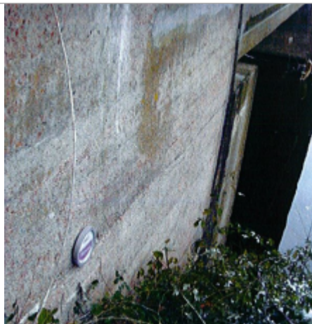
Site pont de Couché
