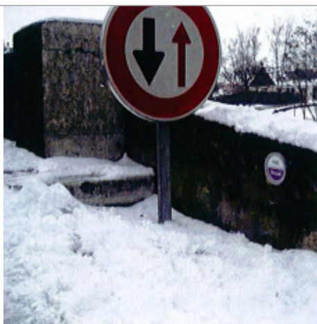
Repere Pont de Chace 1983
