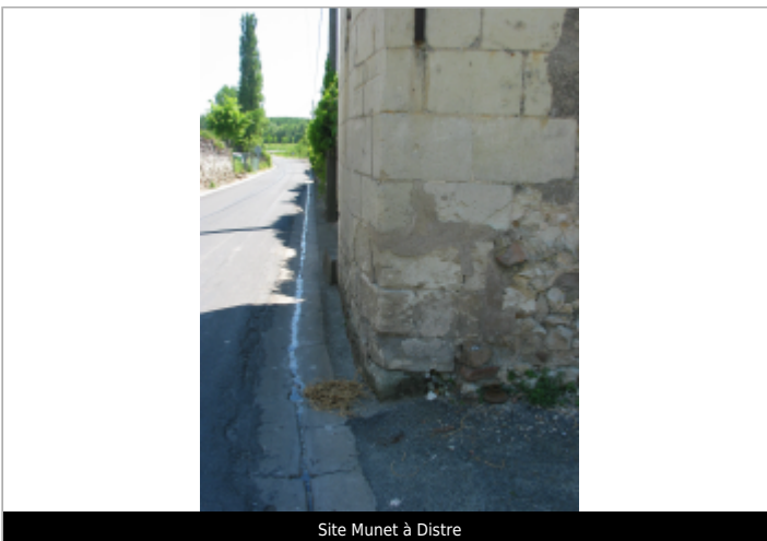
Site Munet à Distre
