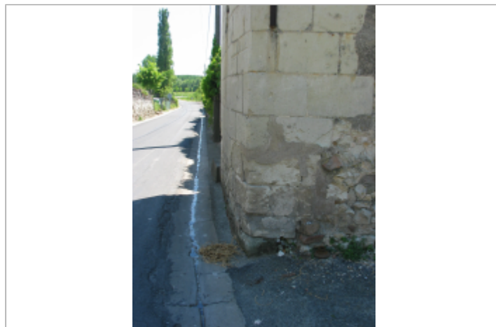
Site Munet à Distre
