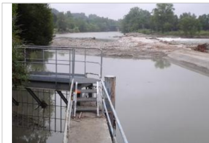
Vue du repère (la trace orange représente le niveau atteint par les eaux) - Auteur : HEA/DDTM
