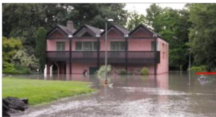
Vue du repère durant la crue - Auteur : HEA/DDTM 64
