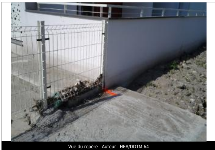
Vue du repère - Auteur : HEA/DDTM 64
