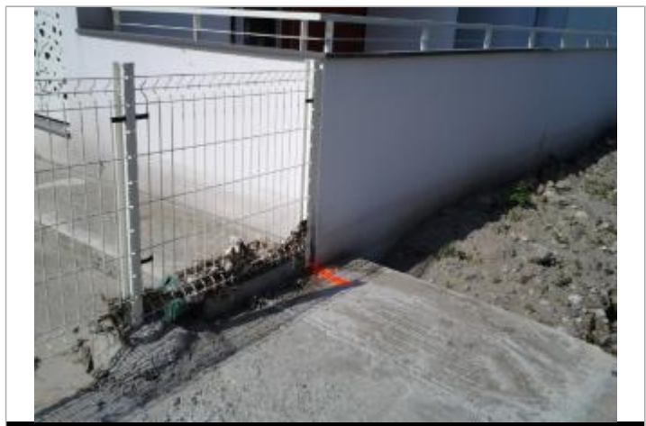
Vue du repère - Auteur : HEA/DDTM 64
