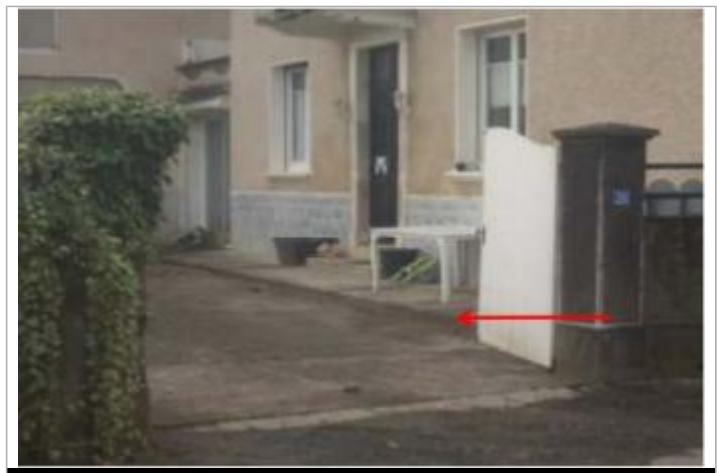
Vue du repère (l'eau a atteint le pied de la dalle au bout de la flèche) - Auteur : HEA/DDTM 64
