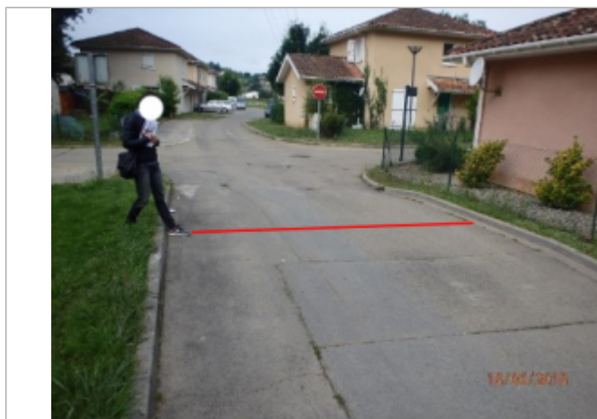
Vue du repère (le trait rouge représente le niveau atteint par les eaux) - Auteur : Artelia/DDTM
