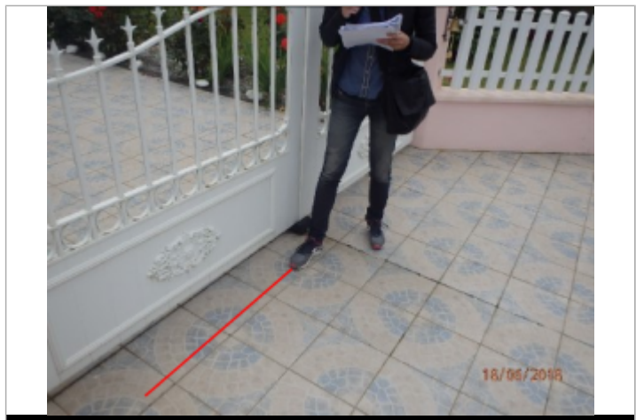
Vue du repère (le trait rouge représente le niveau atteint par les eaux) - Auteur : Artelia/DDTM 64
