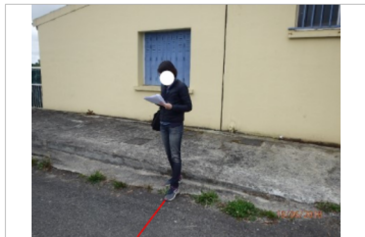
Vue du repère (le trait rouge représente le niveau atteint par les eaux) - Auteur : Artelia/DDTM 64
