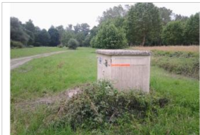
Vue du repère (le trait orange indique le niveau atteint par les eaux) - Auteur : HEA/DDTM 64
