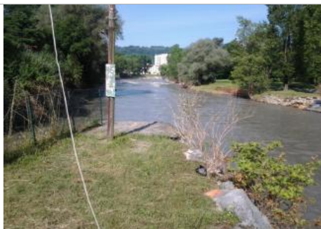
Vue du repère (la marque orange représente le niveau atteint par les eaux) - Auteur : HEA/DDTM
