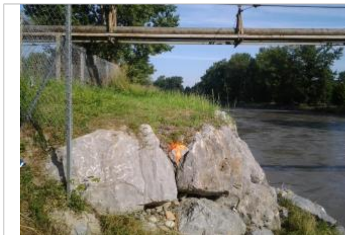
Vue du repère (la trace orange représente le niveau atteint par les eaux) - Auteur : HEA/DDTM
