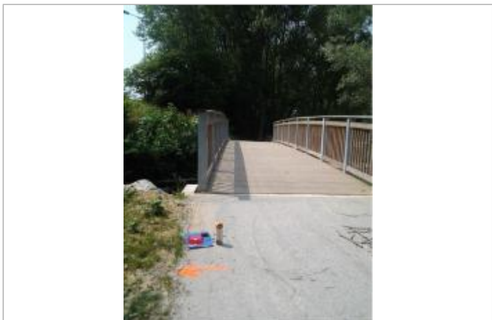
Vue du repère (la flèche orange indique le niveau atteint par les eaux) - Auteur : HEA/DDTM64
