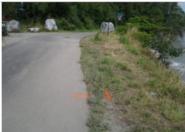
Vue du repère (le trait orange représente la limite de l'inondation) - Auteur : HEA/DDTM 64
