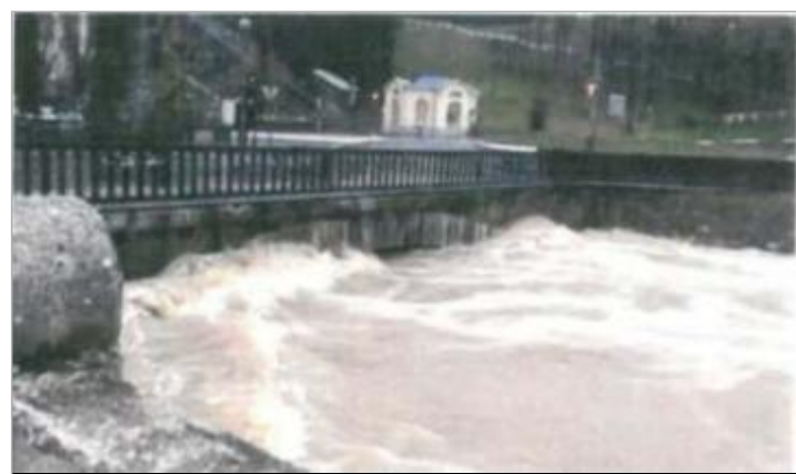
Crue de l'Ousse, vue amont du pont de Lalanne - Auteur : DDTM 64
