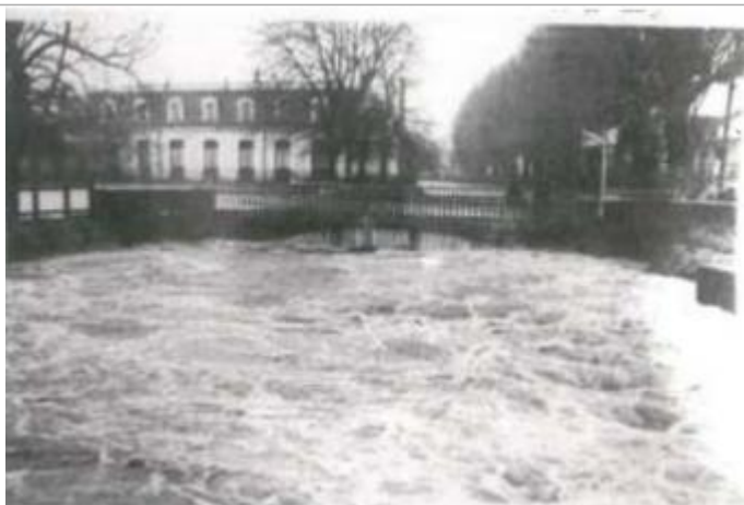
Crue de l'Ousse, vue amont du pont de Lalanne - Auteur : DDTM 64
