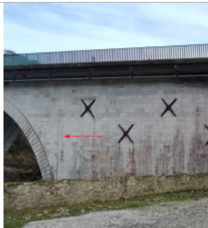
Vue du site (la flèche rouge montre l'échelle de crue) - Auteur : SMBGP
