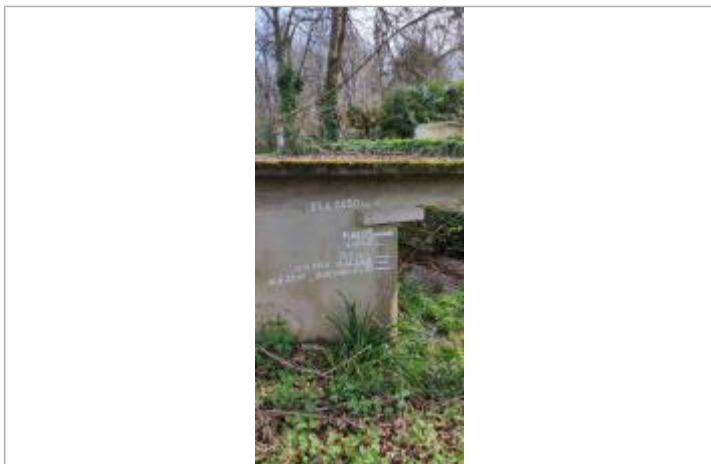
Vue du repère - Auteur : SMBGP
