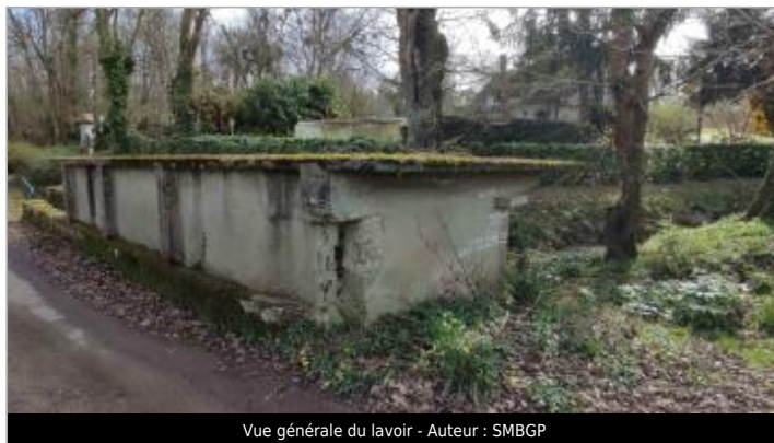
Vue générale du lavoir - Auteur : SMBGP
