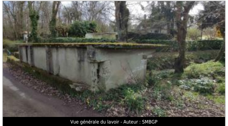
Vue générale du lavoir - Auteur : SMBGP
