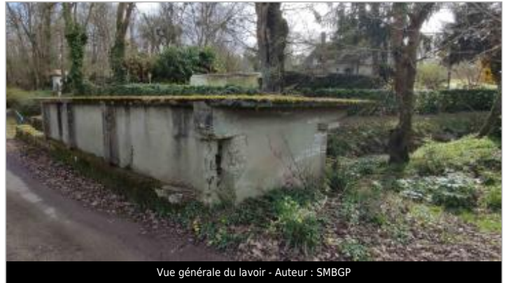
Vue générale du lavoir - Auteur : SMBGP
