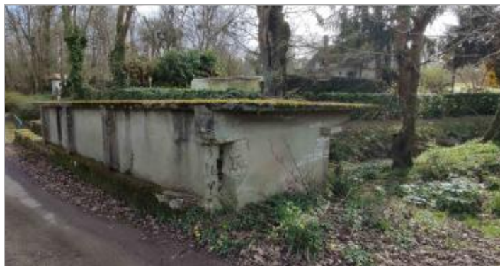
Vue générale du lavoir - Auteur : SMBGP
