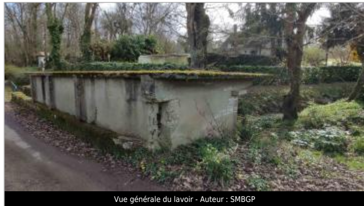
Vue générale du lavoir - Auteur : SMBGP
