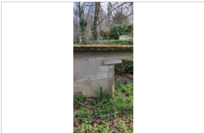
Vue du repère - Auteur : SMBGP
