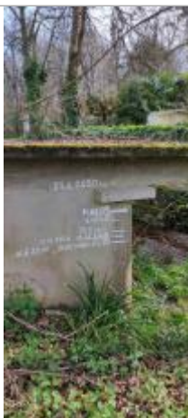
Vue du repère - Auteur : SMBGP
