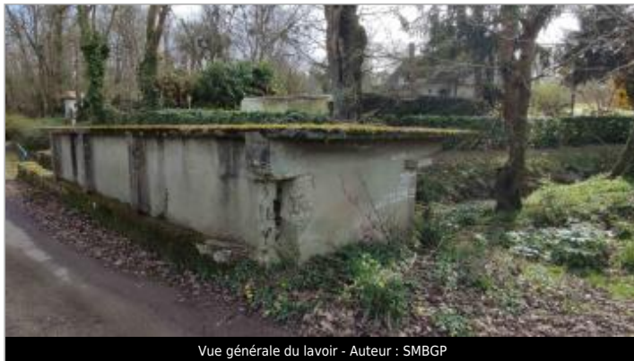
Vue générale du lavoir - Auteur : SMBGP
