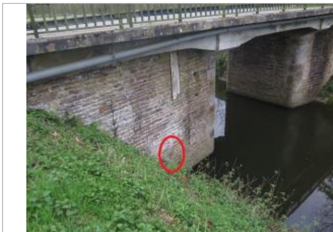
amont rive gauche pont de la RD 36 en amont de l'écluse de Mons (bras navigable)
