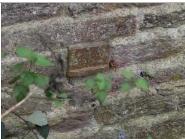
Repère de la crue du 4 janvier 1936
